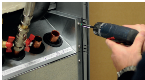
3. Avlägsna kylmodulens fästskruvar.
