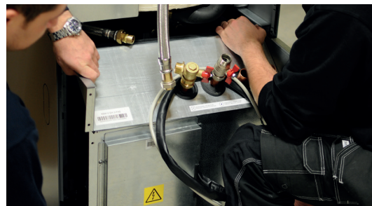
5. Dra ut kylmodulen genom att med hjälp av bärhandtagen först lyfta modulen något uppåt.
