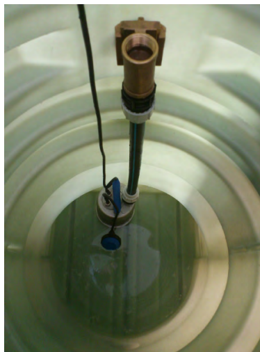
Pumpinredning monterad i kombibrunnen som nu blivit en pumpbrunn inklusive pump.
