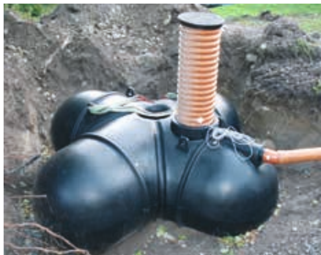
Installation av Wavin slutna tank 3000 I PE
